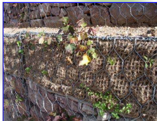
Foto - Le fotografie illustrano un intervento di consolidamento idrogeologico e sostegno realizzato con Gabbioni Rinverdibili. L'intervento si colloca nell'ambito della realizzazione e completamento della Pista Ciclo-Pedonale Circumlacuale del Lago di Molveno situato nel Parco Naturale Adamello Brenta (TN). (per gentile concessione Provincia Autonoma di Trento Servizio Conservazione della Natura e Valorizzazione Ambientale)
