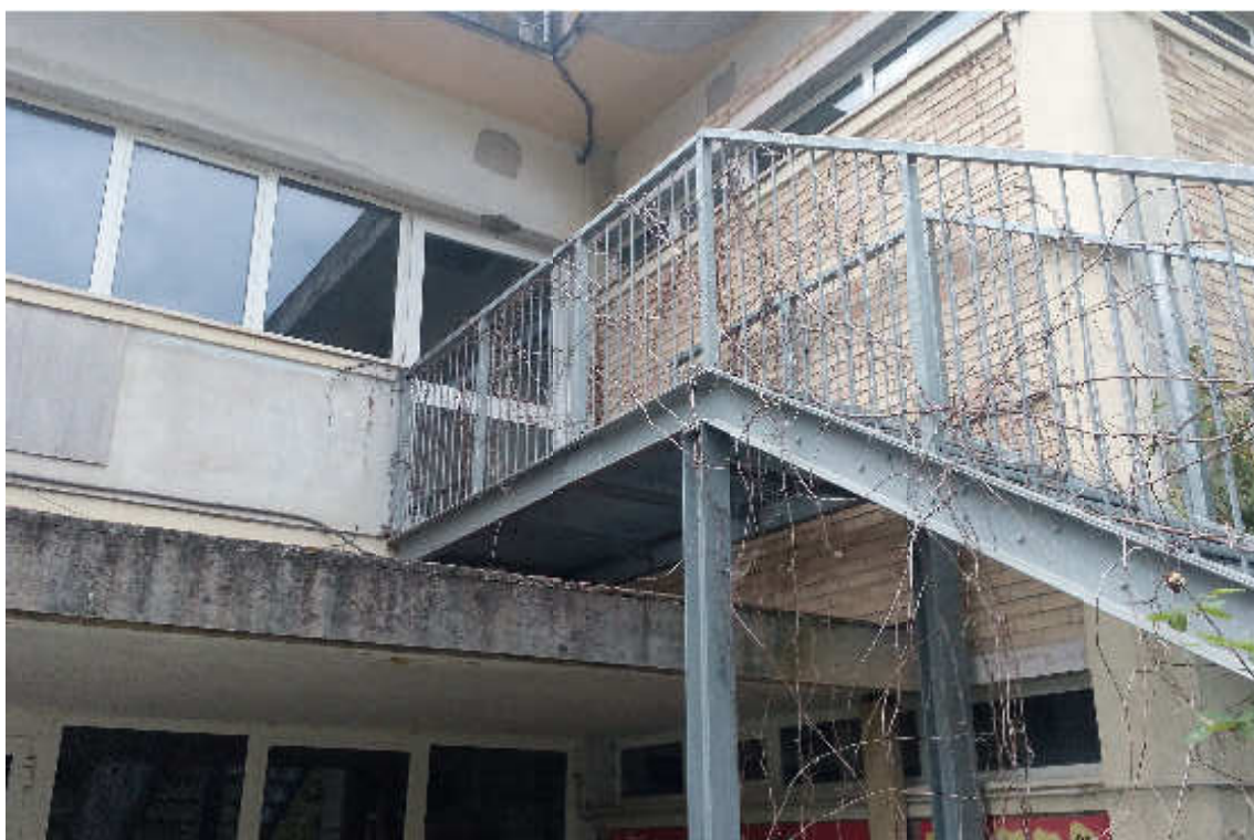
plesso A - scala di emergenza in acciaio da smontare per poi essere destinata alla scuola Conti o Mazzini
