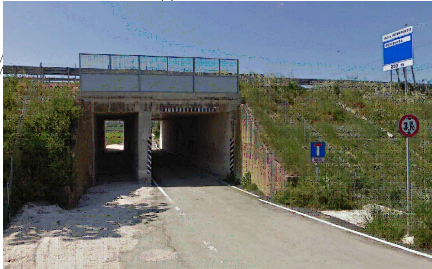
OPERA D'ARTE ESISTENTE - SOTTOPASSO STRADALE SCATOLARE IN C.A. ALLA SS76
