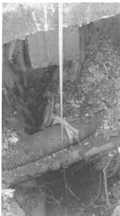
Foto 2: scavo in aderenza alla fondazione
