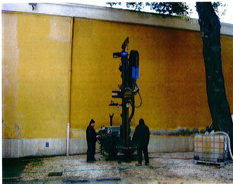
Fotografia 10 – Esecuzione sondaggio geognostico n.3
