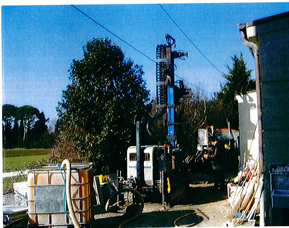
Fotografia 6 - Esecuzione sondaggio geognostico n.2
