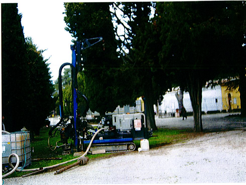
Fotografia 1 - Esecuzione sondaggio geognostico n.1
